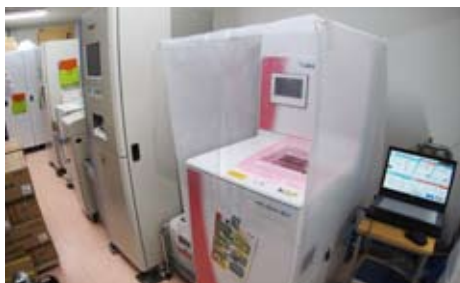
震度6にも耐える機械室
