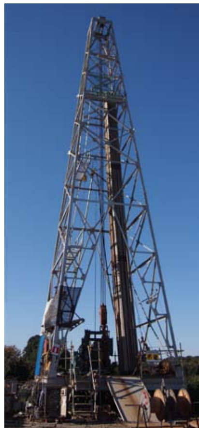
地下1500㍍まで掘削したやぐら（撤去済み）
